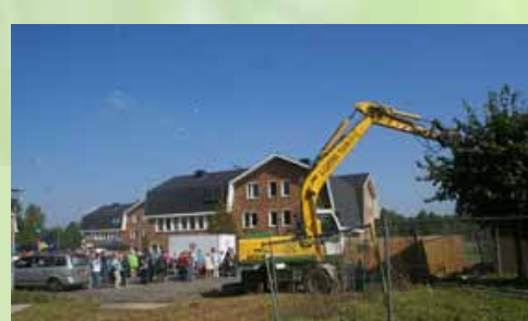
Ceremonieel start sloopwerkzaamheden door van Casteren voor de volgende fase
